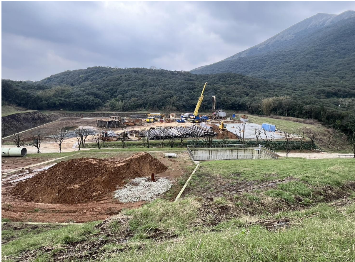
圖五 「金山硫磺子坪地熱示範區」施工現況照片
