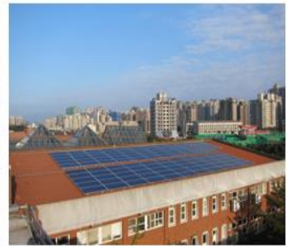
新北特教 459.9kWp
