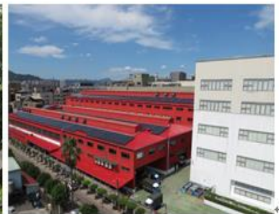
廷順企業 249.6kWp
