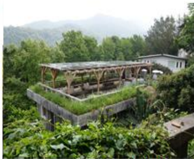
一人一千瓦 9.75kWp
