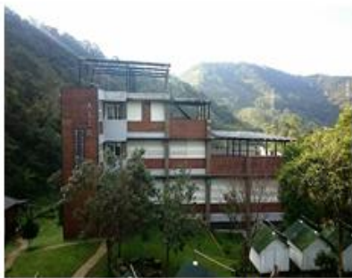
五福華廈 9kWp
